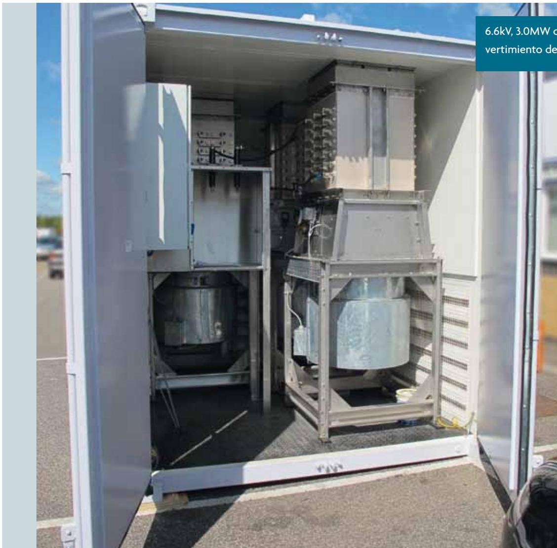
6.6kV, 3.0MW carga de lastre para vertimiento de carga de turbina
