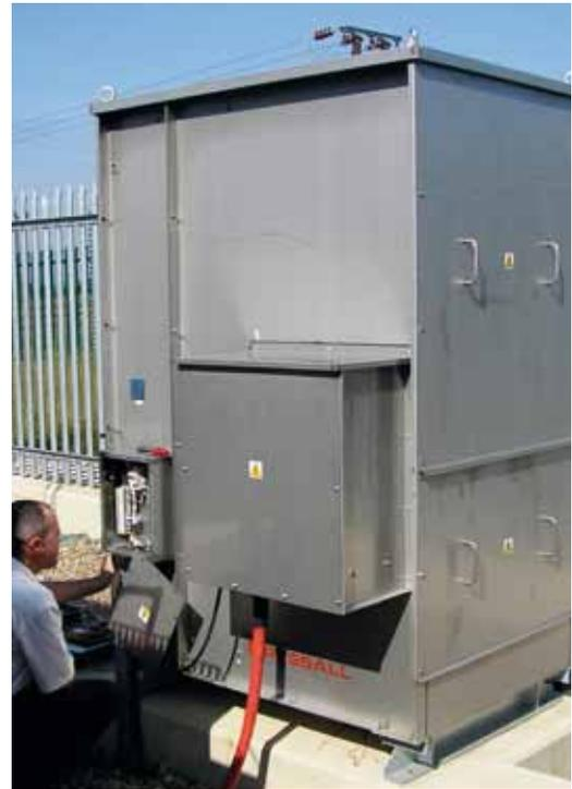
Unidad NER y asamblea vacío contactor en una subestación de utilidad en el Reino Unido.
